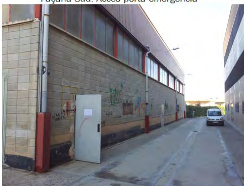
Façana Est, tres portes emergència.
