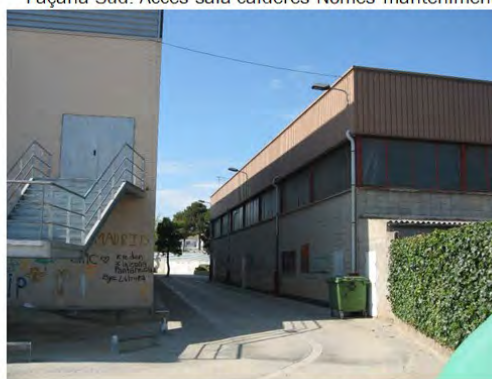
Carreró de la Façana Est.
