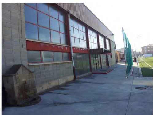
Accés principal de la façana Oest. Accés del Camp de futbol.
